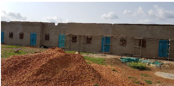
Sanierung der Jungenschule in Darassalam
