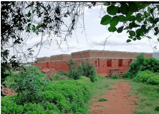
Rohbau des 2. Kindergartens in Hilat Al Bir
