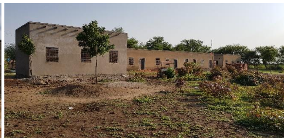
Sanierung der gemischten Basisschule in Umkitir
