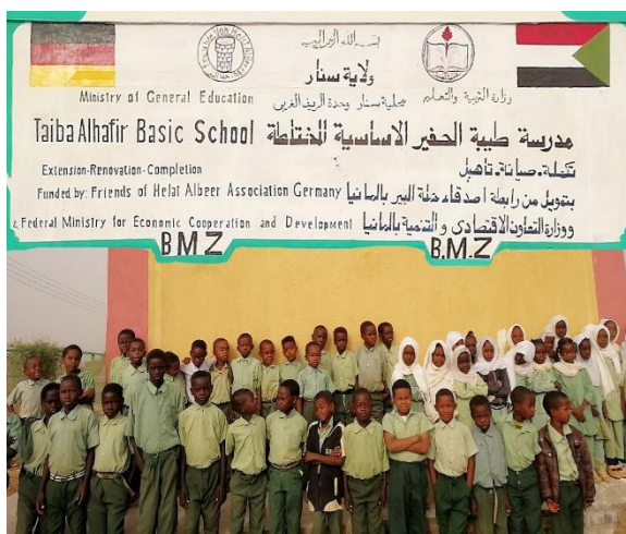
Erweiterte und sanierte Basisschule in Taiba Alhafir
